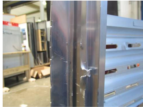
Bild 8 Schäden aus der manuellen Prüfung der Mauerwerksanker
