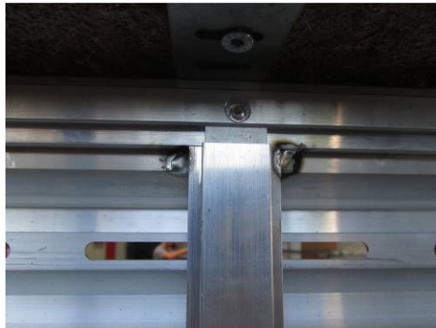
Bild 3 Beschlagteil des Probekörpers
